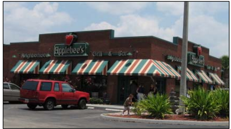
Actual Site Photo
